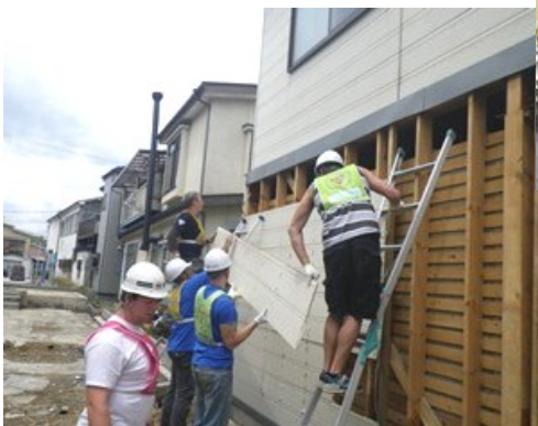
← シアトルYからの大工さん先導で行われた外壁壊しとヘドロの除去作業 ↑ シアトルYの方々との交通整理協力助っ人です！
